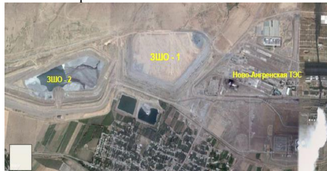
Рис.1. Местоположение золошлаковых отходов Ново-ангренской ТЭС
